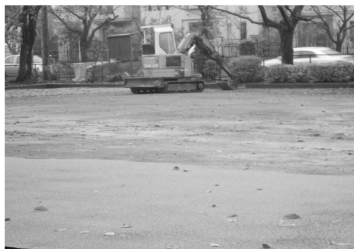
公園の表土は重機で除去
