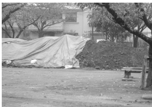
公園内の表土を山積み
